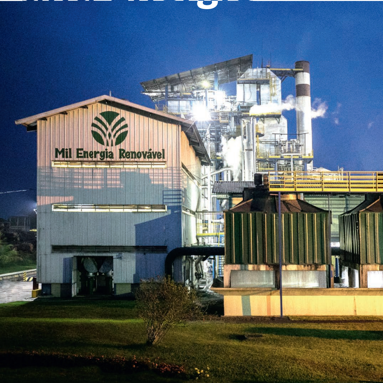
Bild: Biomassekraftwerk MIL Energia Renovável, Brasilien
