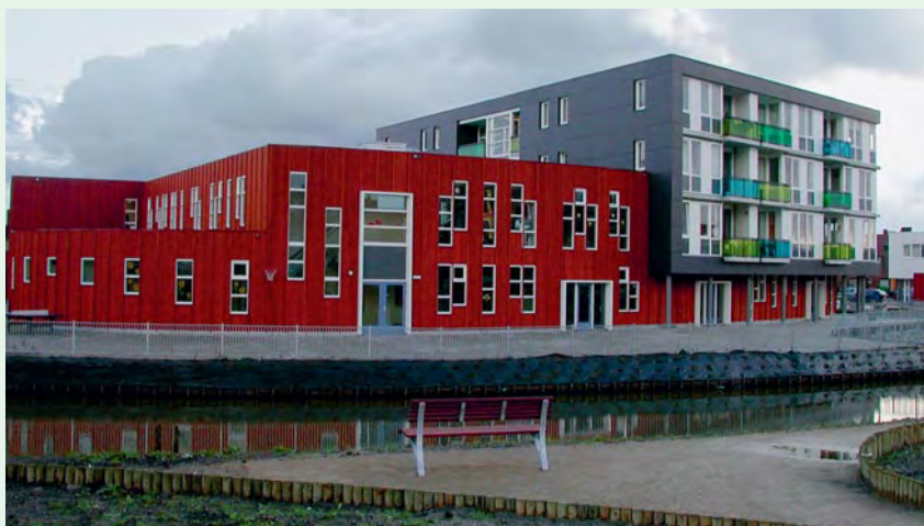
Infrastrukturprogramme fördern Bauten von Schulen und Spitälern
